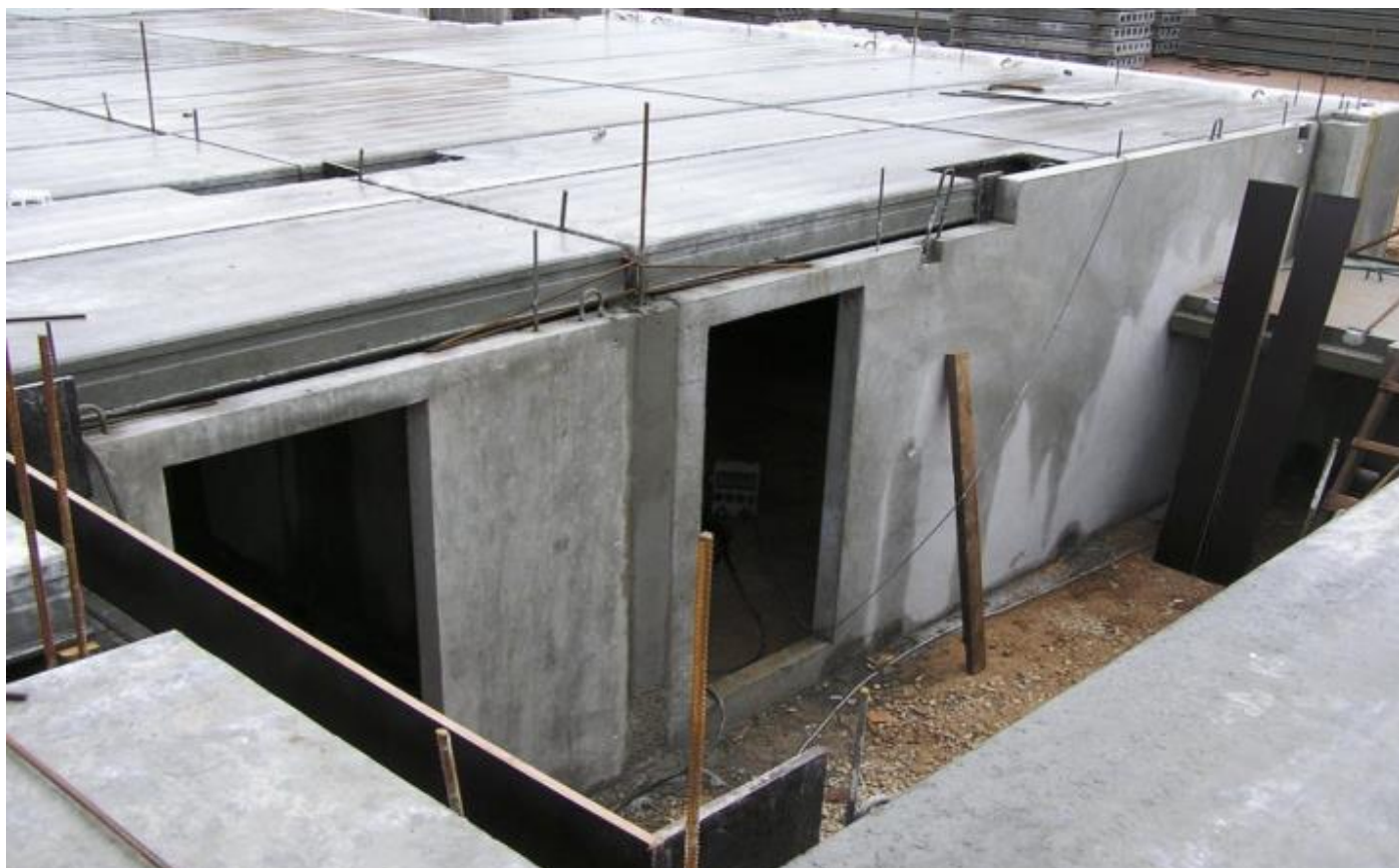
МОНТАЖ ЦОКОЛЬНОГО ЭТАЖА И ПЕРЕКРЫТИЕ ПУСТОТНОЙ ПЛИТОЙ
