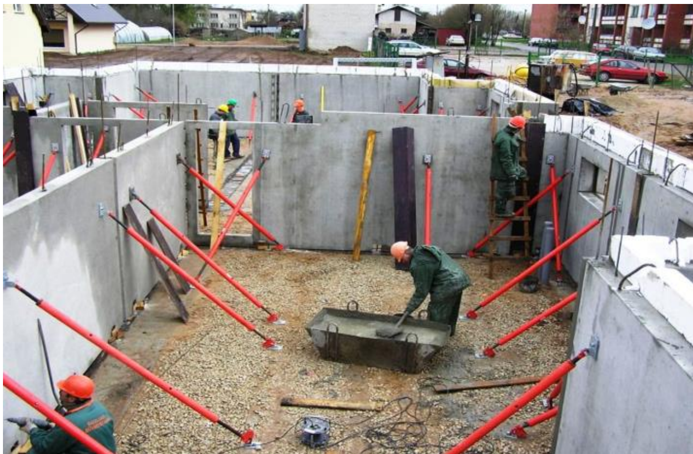
МОНТАЖ ЦОКОЛЬНОГО ЭТАЖА И ПЕРЕКРЫТИЕ ПУСТОТНОЙ ПЛИТОЙ
