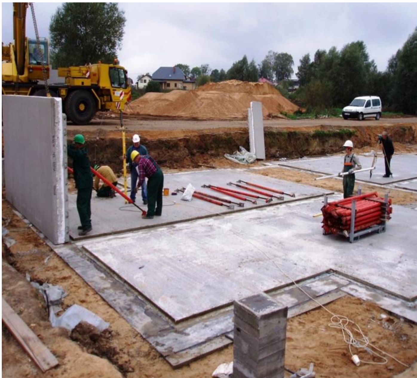
ЗАЛИВКА ФУНДАМЕНТНОЙ ПЛИТЫ, МОНТАЖ ЦОКОЛЬНОЙ ПАНЕЛИ
