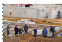
Начало монтажа надземной части
